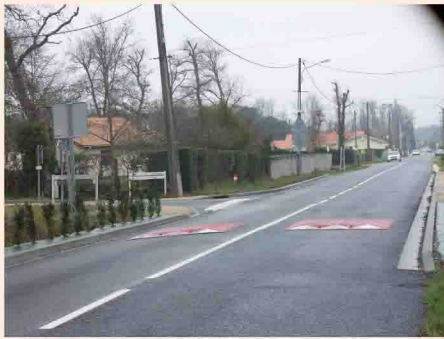
Carrefour de Glomeau : Aménagement d'une zone à 30 km/h avec pose de coussins berlinois et matérialisation de l'entrée du village par une haie végétale.
