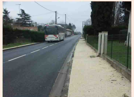
Les trottoirs du centre bourg ont été réalisés par les employés communaux.
