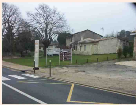
Rue du Centre – suite à la démolition de la Maison, aménagement d'un espace vert et de trottoirs pour la continuité du cheminement piéton.
