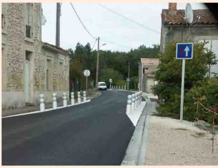
Entrée Nord – Route de Cissac Aménagement d'une écluse et d'une zone 30 km/h afin de réduire la vitesse des véhicules entrant dans le bourg.
